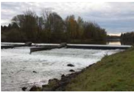
Künstliche Sohlschwellen zerschneiden Lebensräume
